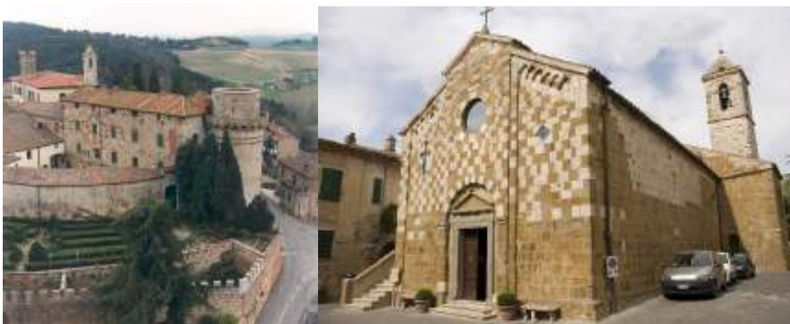
Figura 27 A sinistra la torre del castello Cacciaconti; a destra la chiesa dei SS. Pietro e Andrea
