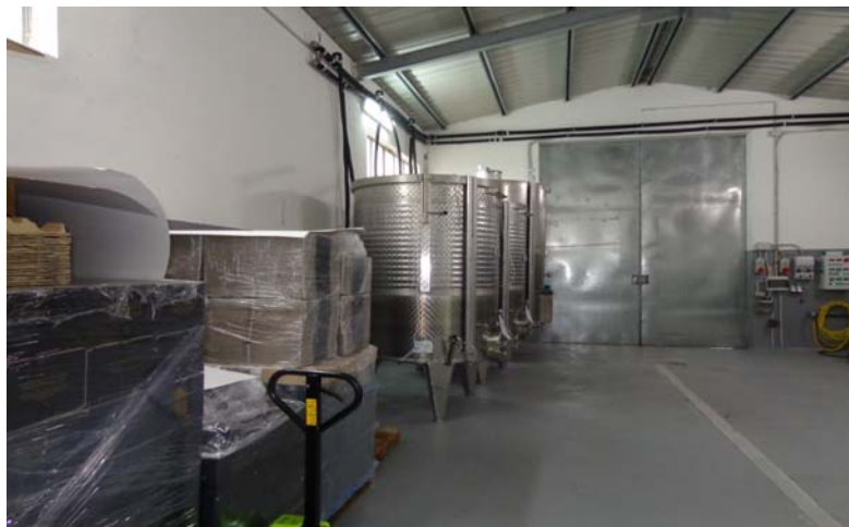
Dettaglio della cantina di trasformazione
