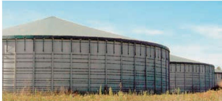
Fig. 10 Vasche circolari coperte con telo plastomerico (fonte: Cbs).
