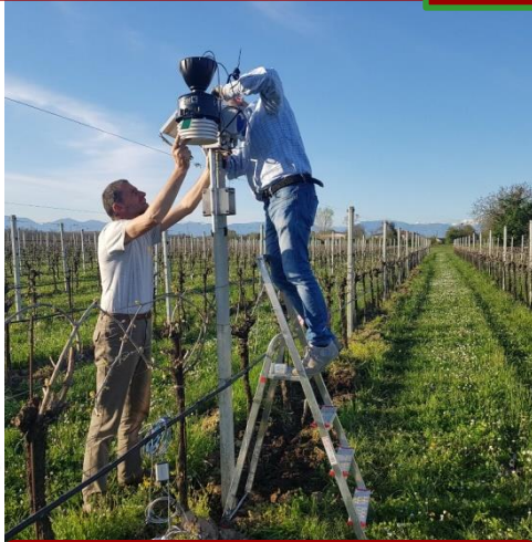
Installazione di stazione meteo con nuova sensoristica sperimentale
