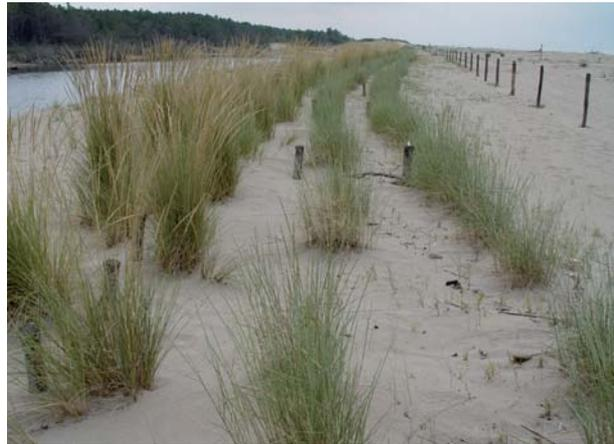
Intervento di ricostituzione della duna realizzato mediante piantumazione di *Agropyron junceum* (L.) Beauv. e *Ammophila littoralis* (Beauv.) Rothm. in località Foce del Torrente Bevano (Ravenna). È stato utilizzato materiale vegetale autoctono, allevato *ex situ*. Aspetto della copertura vegetale a 20 mesi dall’impianto. (Foto Nicola Merloni)
