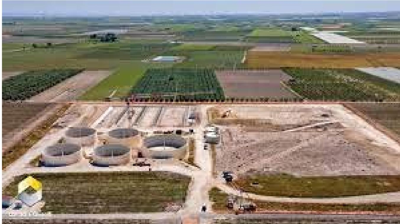
Nel 2023, l'azienda Corradi & Ghisolfi ha realizzato nell'azienda agricola Arca, in provincia di Foggia, un impianto alimentato con sansa di olive bifasica, foglie di ulivo, reflui avicoli e colture marginali per la produzione di biometano e digestato.
