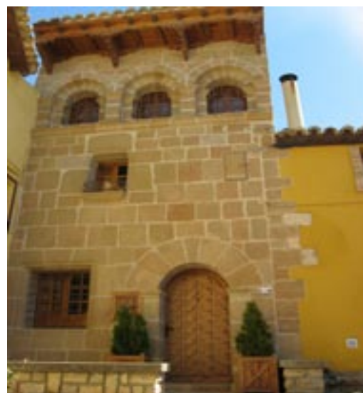
Foto 5: Spagna (Aragona) - Ristrutturazione di case per turismo rurale
