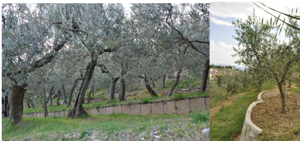
Figura 7 - A sinistra terrazzamenti ricostruiti con blocchi prefabbricati in cemento in località Collepino (frazione di Spello); a destra lunette a Trevi recuperate utilizzando il cemento nella muratura
