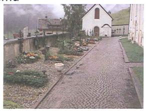
E' stato sistemato il muro eliminando le numerose infiltrazioni di acqua. Si è provveduto al rifacimento del vialetto di accesso con una nuova sistemazione.
