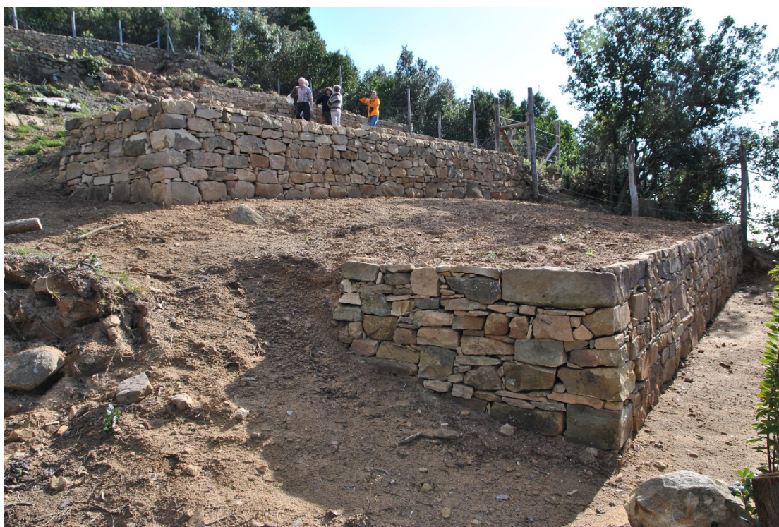
Fig. 9. Il restauro dei terrazzamenti storici di Case Lovara, proprietà del FAI posta nel territorio del Parco delle Cinque Terre, realizzato dallo spin off Horizons dell'Università di Firenze. La realizzazione del lavoro ha dovuto superare notevoli difficoltà dal punto di vista autorizzativo, anche riguardo al recupero delle tipiche “pergole basse” caratteristiche della viticoltura tradizionale della zona. In quest'area l'abbandono ha visto una riforestazione del 30% e una riduzione dei terrazzamenti del 65% negli ultimi 30 anni. Le grandi frane avvenute nel disastro del 2011, sono per l'85% avvenute su terrazzamenti abbandonati e ricoperti da vegetazione arborea ed arbustiva.
