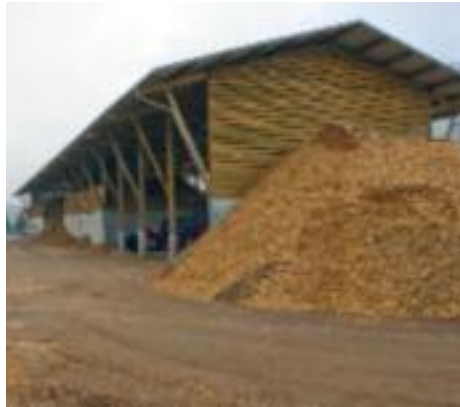
↑ Le bâtiment sur la photo est le séchoir à bois construit en 2004 à l'initiative des menuisiers et charpentiers du village. Objectif : utiliser la chaleur produite par la chaudière à bois pour faire sécher, durant deux semaines, le bois utilisé pour la construction. Le bois est plus léger et plus sain car on n'a pas besoin de le traiter, les insectes ne l'attaquent pas.
