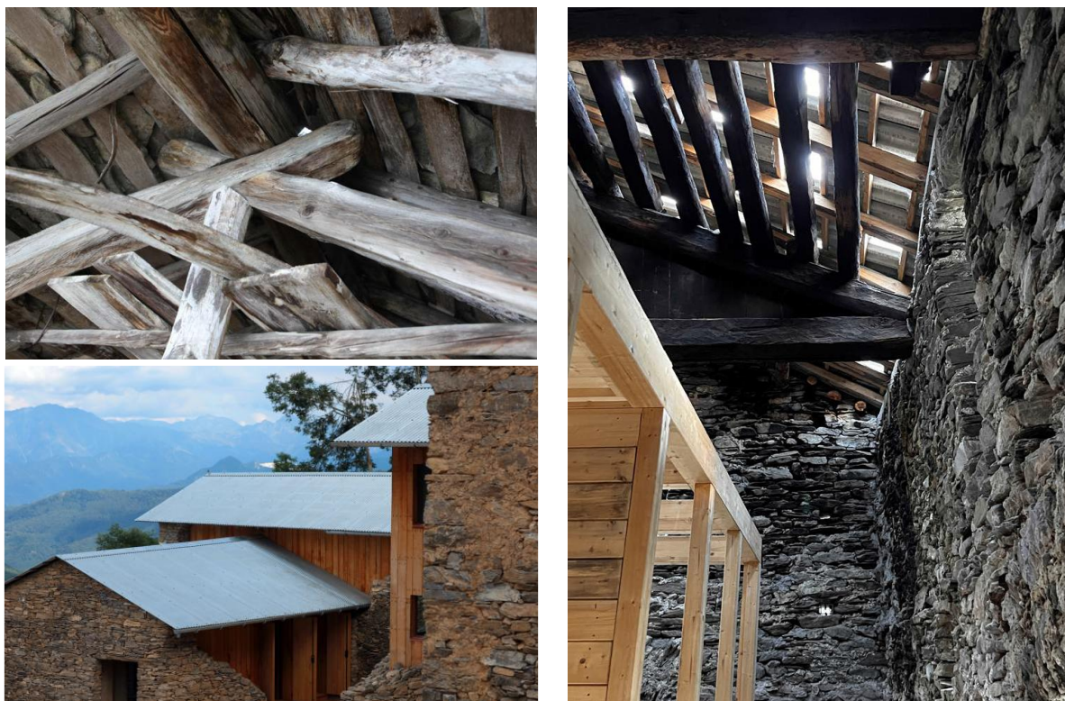
Fig.5.9.2,4,5 - Particolari di coperture.
