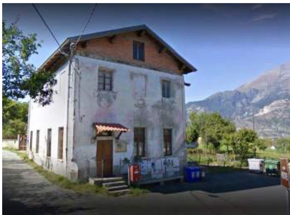
Figura 51 – GAL Escartons e Valli Valdesi. Restauro facciata ex-scuola borgata Meitre di Bussoleno (TO). Fonte: Google Maps.
