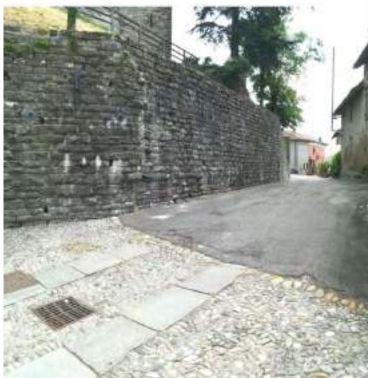
Figura 48 – GAL Borba. Intervento di riqualificazione pavimentazione via di accesso al nucleo storico di Trisobbio (AL). Fonte: Adamo, 2021
