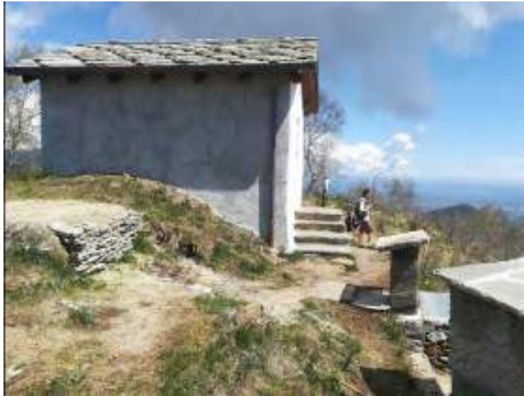
Figura 58 - GAL Valli di Lanzo, Ceronda e Casternone. Ristrutturazione Cappella Madonna della Neve del Monte Lera nei pressi di Givoletto (TO). Nuova funzione: area di sosta per visitatori. Fonte: Google Maps
