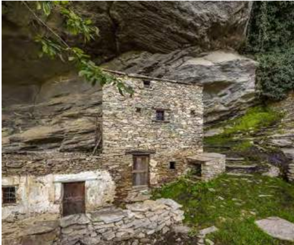
Figura 53 – GAL Tradizione delle Terre Occitane. Riqualificazione di alcuni manufatti del sito di Balma Boves, comune di Sanfront (CN). Fonte: http://www.balmaboves.it/
