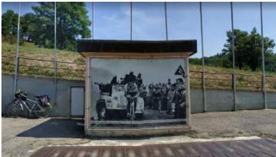
Figura 60 - Restauro facciata locali municipali di Castellania Coppi (AL). Nuova funzione: arte pubblica. Fonte: Comune di Castellania Coppi
