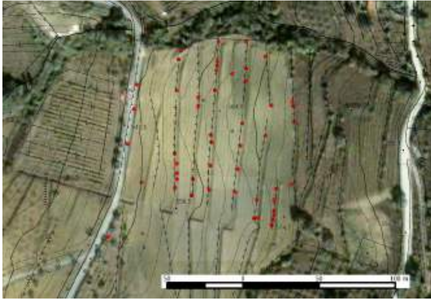
Figura 129: Crolli e spancamenti localizzati con GPS sui muri del vigneto oggetto di osservazione
