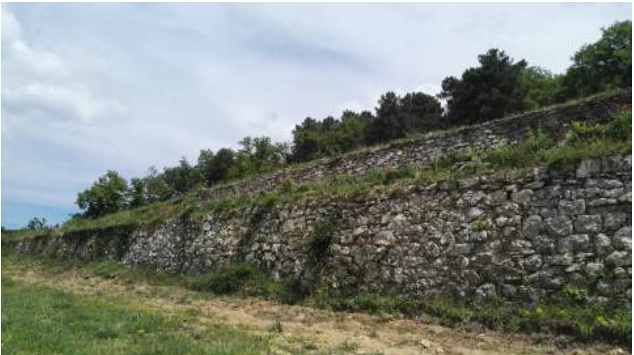
Figura 94 Terrazzamenti costruiti su una pendice soggetta a pendenza molto elevata.
