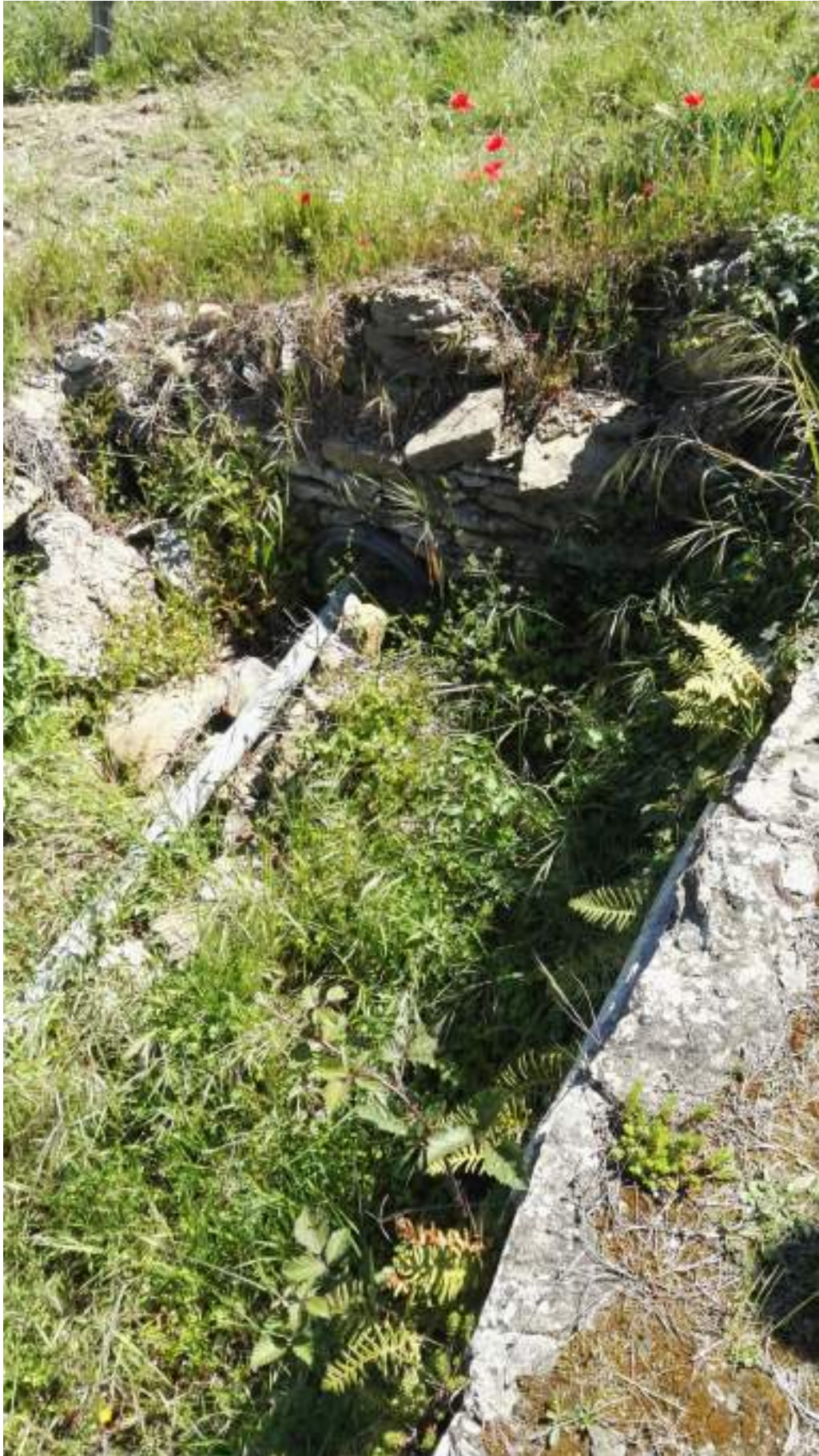
Figura 95 Sistemazione idraulica annessa ai terrazzi, la gattaiola.
