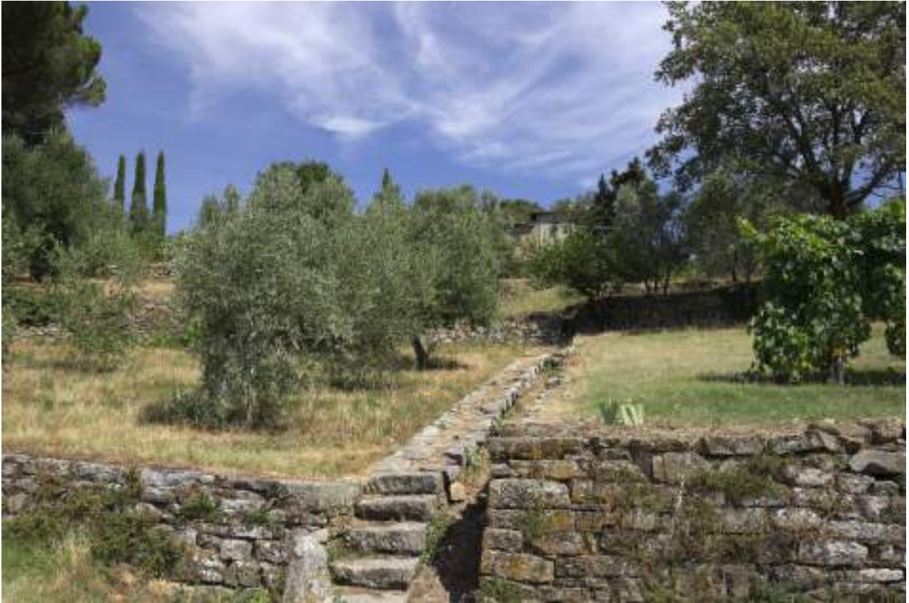
Figura 93 Scalette di accesso al terrazzamento e canali di scolo delle acque
