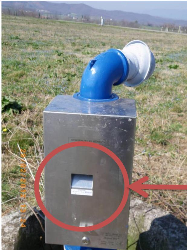
*Idrante automatizzato per la regolazione della distribuzione dell'acqua attraverso una "tessera elettronica"*
