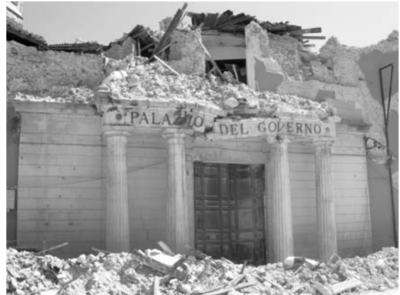
Aquila - Ein Bild der Zerstörung nach dem Erdbeben vom 6. April 2009 Aquila - un'immagine della distruzione del terremoto del 6 aprile 2009
