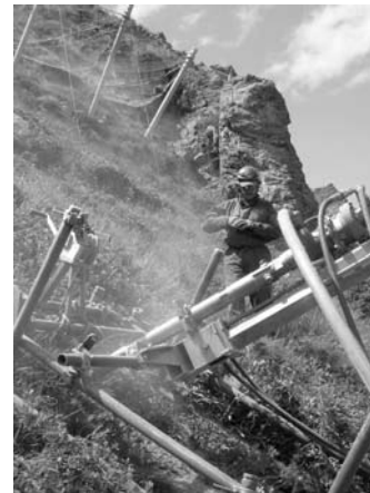
Bohrarbeiten auf der Baustelle „Lawinverbauung Schneelahn“ Trivellazione di pali sul cantiere "valanga neve"
