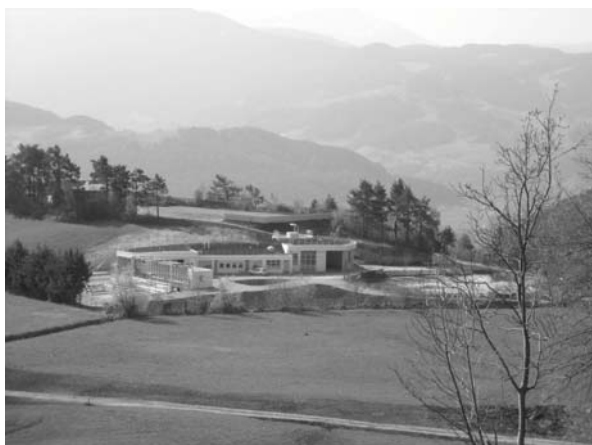
Kläranlage Siffian - Ritten Impianto di depurazione di Siffiano - Renon
