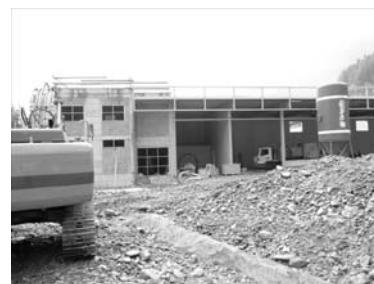
Baustelle Straßen- stützpunkt Sterzing Costruzione punto logistico Vipiteno
