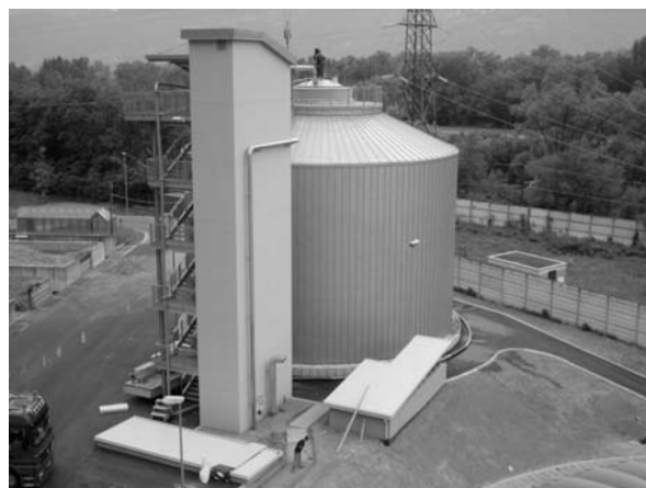
Kläranlage Meran - Neuer Faulturm Impianto di depurazione di Merano - Nuovo digestore
