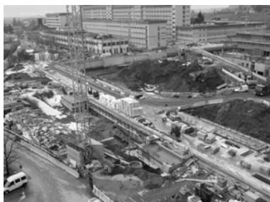
Baustelle am Regional- krankenhaus in Bozen Cantiere presso l'ospedale regionale a Bolzano
