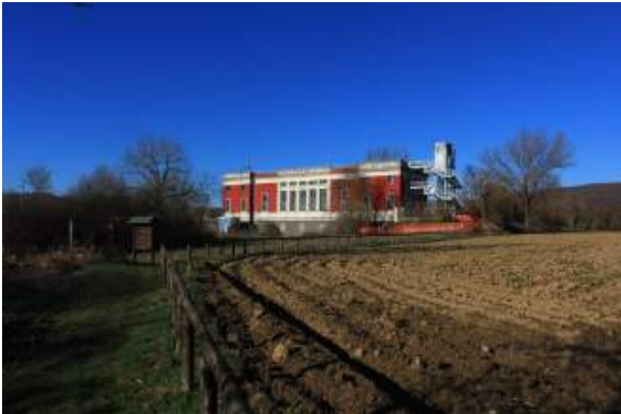
Il fabbricato delle idrovore
