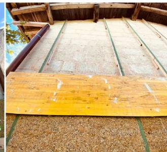
Intonaco in terra cruda direttamente sul supporto in paglia e calce spessore minimo di 1 cm
