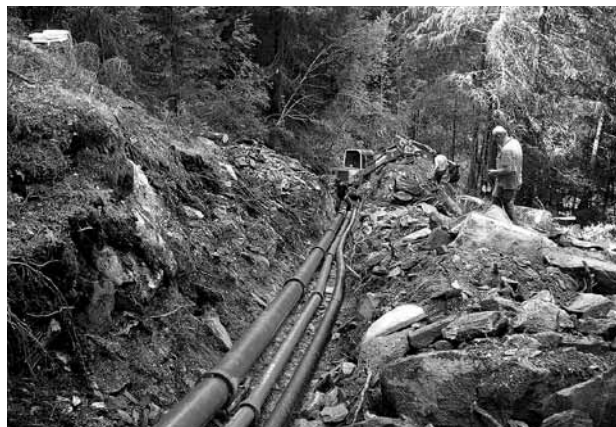
Posa in opera di condotte per la piccola centrale idroelettrica di Moso.
