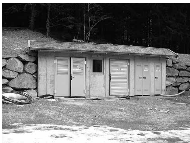
Centrale idroelettrica „Al Gallo inferiore“
