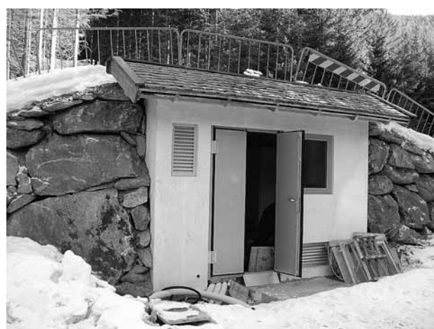
Centrale idroelettrica „Al Gallo superiore“
