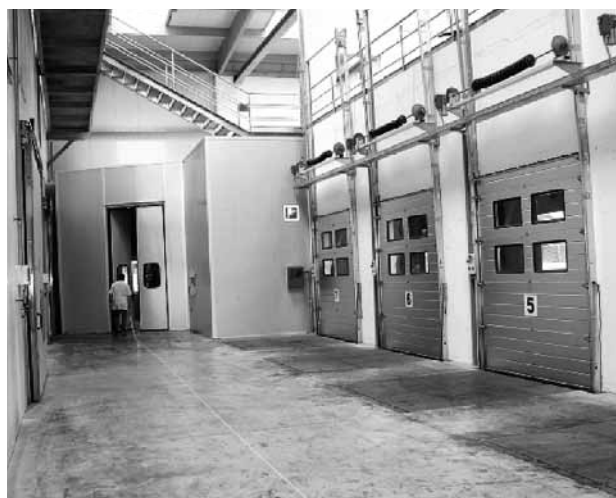
Rampe di carico dei mezzi di trasporto della merce commercializzata
