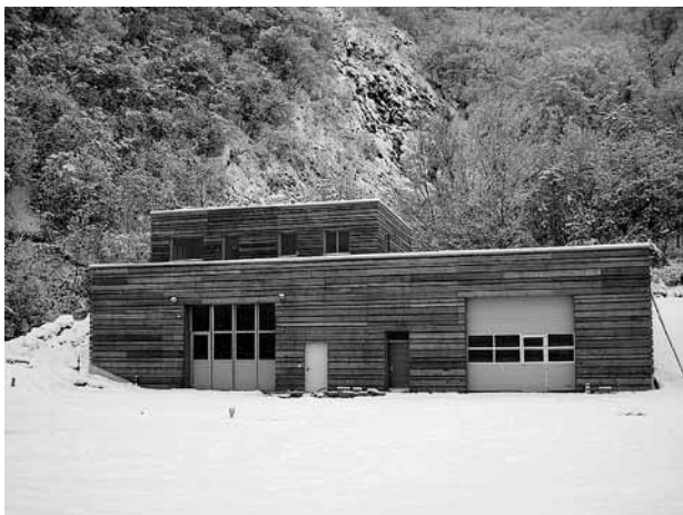
Nuovo magazzino e nuovi servizi igienici nel vivaio forestale di Piglon realizzato in collaborazione con l'azienda Laimburg.
