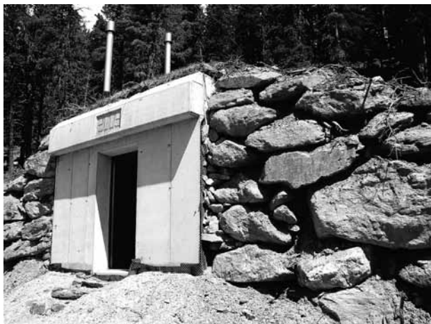
Serbatoio di raccolta
