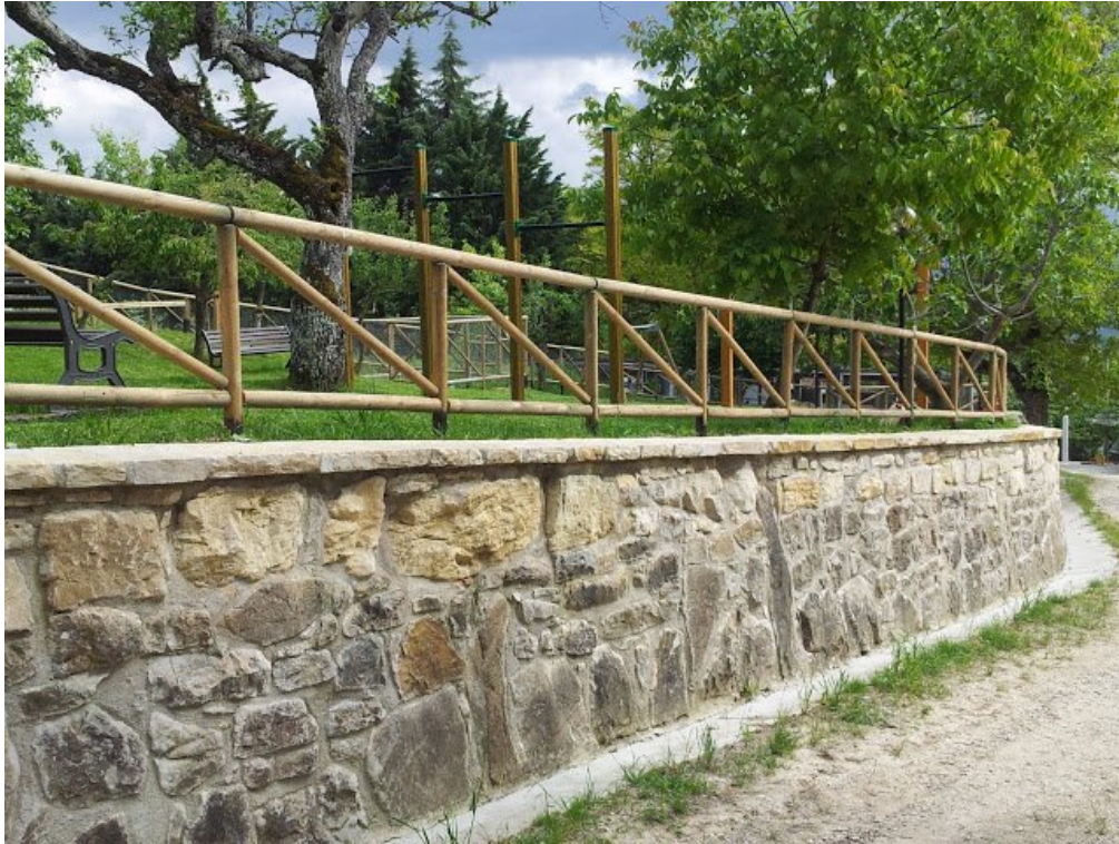
La staccionata in legno di quercia realizzata con i fondi PSR 2007/2013
