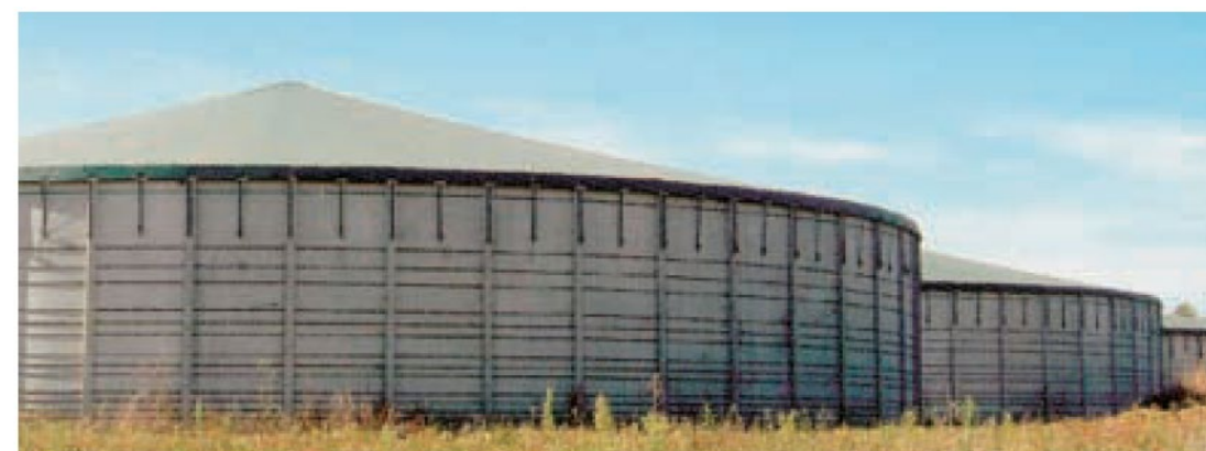
Fig. 10 Vasche circolari coperte con telo plastomerico (fonte: CBS).
