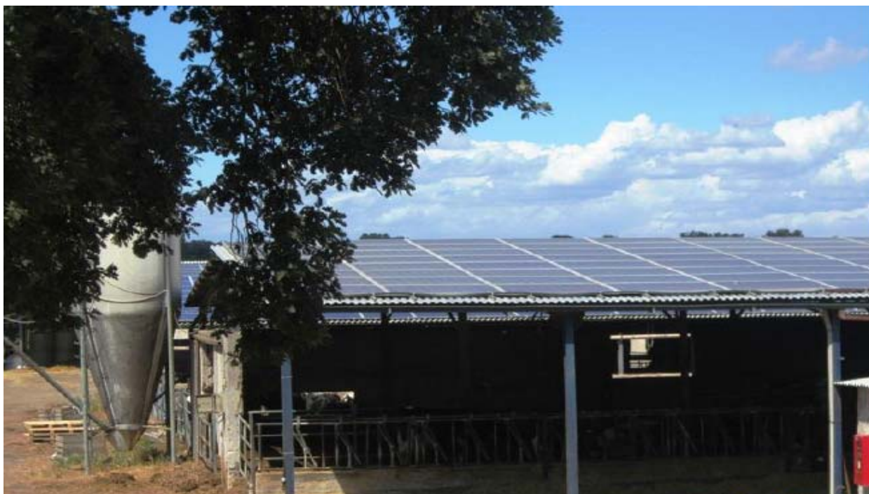
Copertura con pannelli fotovoltaici
