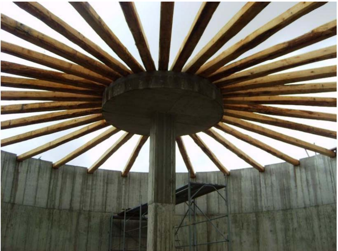
Digestore anaerobico presente in azienda (in fase di realizzazione)
