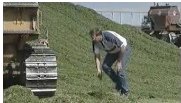
Realizzazione silo: riempimento, compresione e copertura
