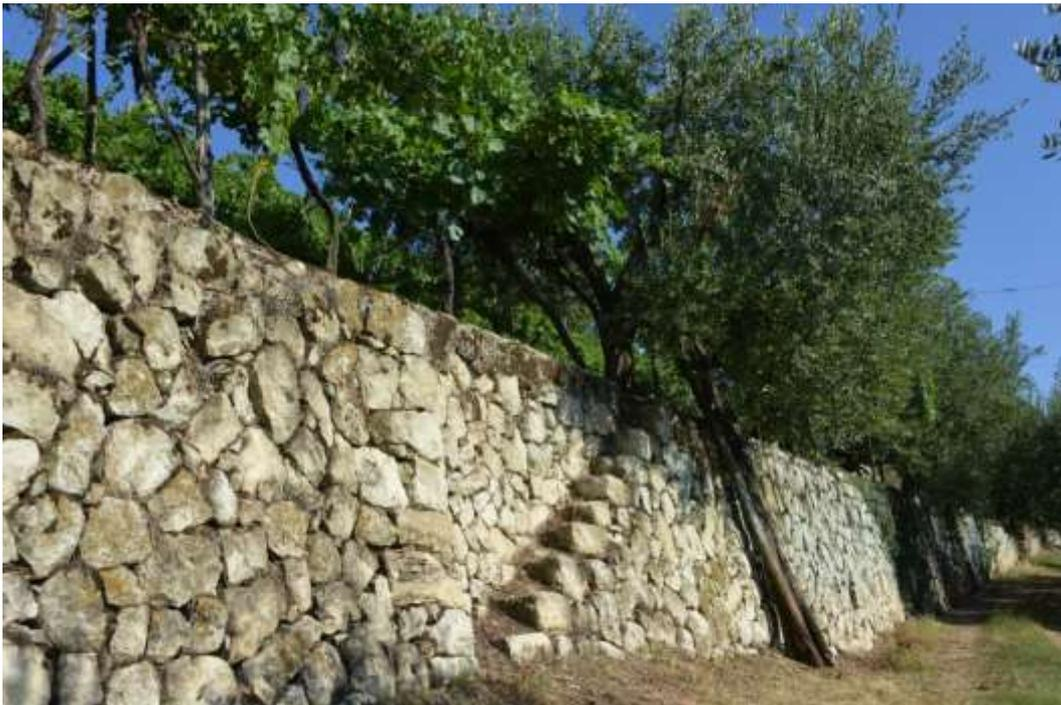
*Muro a secco in un terrazzamento: di particolare interesse la scala ricavata tra i conci del muro.
