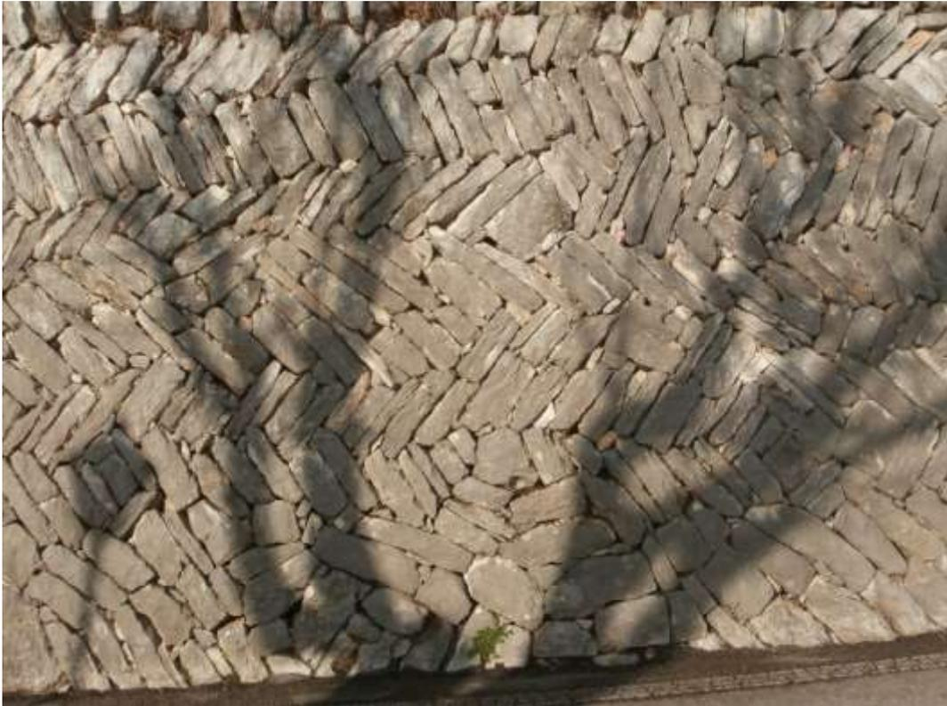
*Muro a secco realizzato con elementi posti a spina di pesce*
