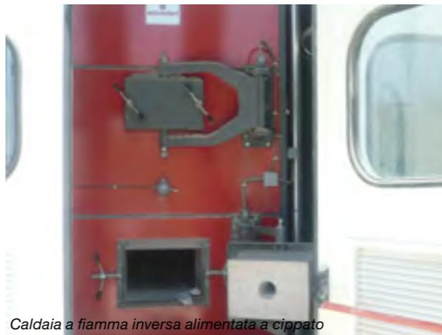
Caldaia a fiamma inversa alimentata a cippato
