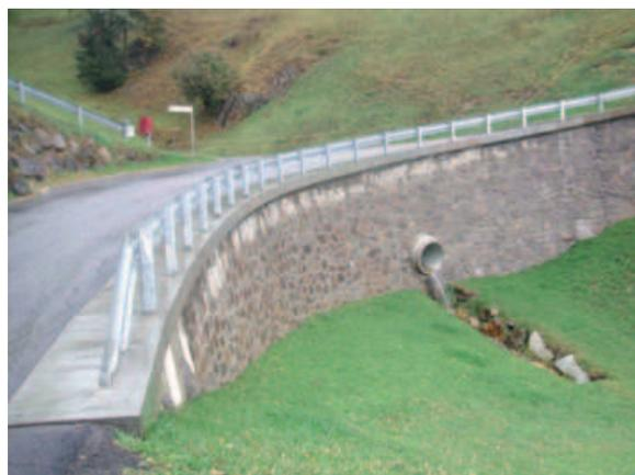
La sistemazione ha riguardato il risanamento dei cedimenti della precedente strada sterrata, la costruzione di tombini e drenaggi, l'ampliamento della sede all'incrocio con la Provinciale e la sistemazione dei cordoli, opere di disaggio per evitare il rischio di cadute massi sulla strada ed opere di ingegneria naturalistica per il consolidamento dei cigli. L'opera è stata completata con l'asfaltatura della sede stradale e con la messa in sicurezza della strada.
