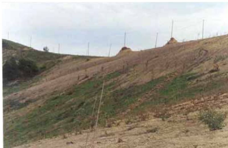
Figura 2(b). Spesso gli impianti sono stati posizionati sulle testate delle aree incise, con risultato di contribuire a incrementare i fenomeni erosivi e a scarsi o nulli risultati in termini di attecchimento delle piante, a causa della asportazione del suolo fertile dovuta al livellamento dell'area di impianto.
