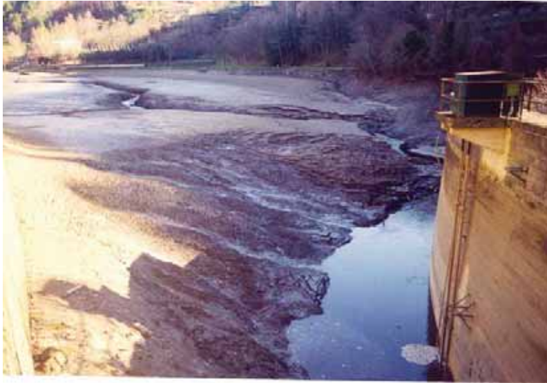
Figura 5.16. Esempio d'esternalità negativa causata dall'erosione: sedimenti nell'invaso artificiale di Londa (Firenze).
