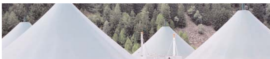
Impianto di biogas a Campo Tures
