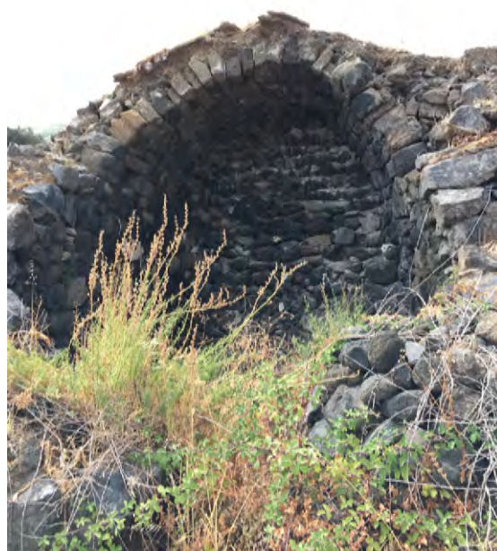
Sezione strutturale di un dammuso con volta a padiglione
