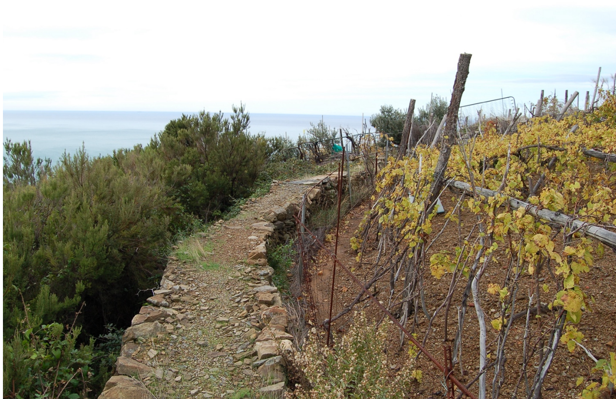
Muro di sostegno sopraelevato per frangivento
