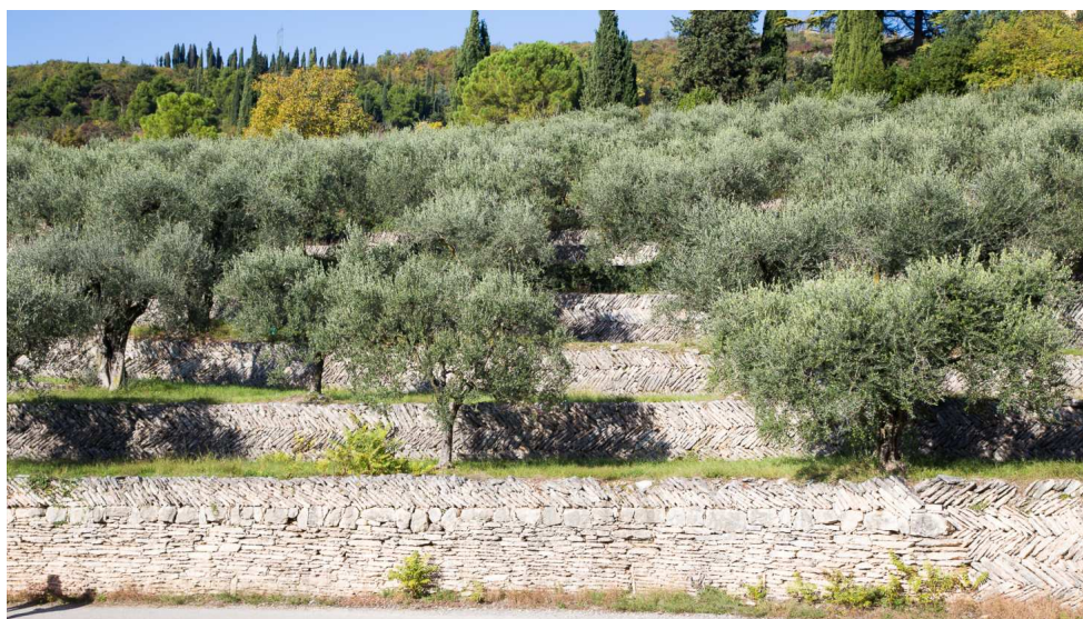
Muri a secco realizzati con scarti di lastame a spina pesce
