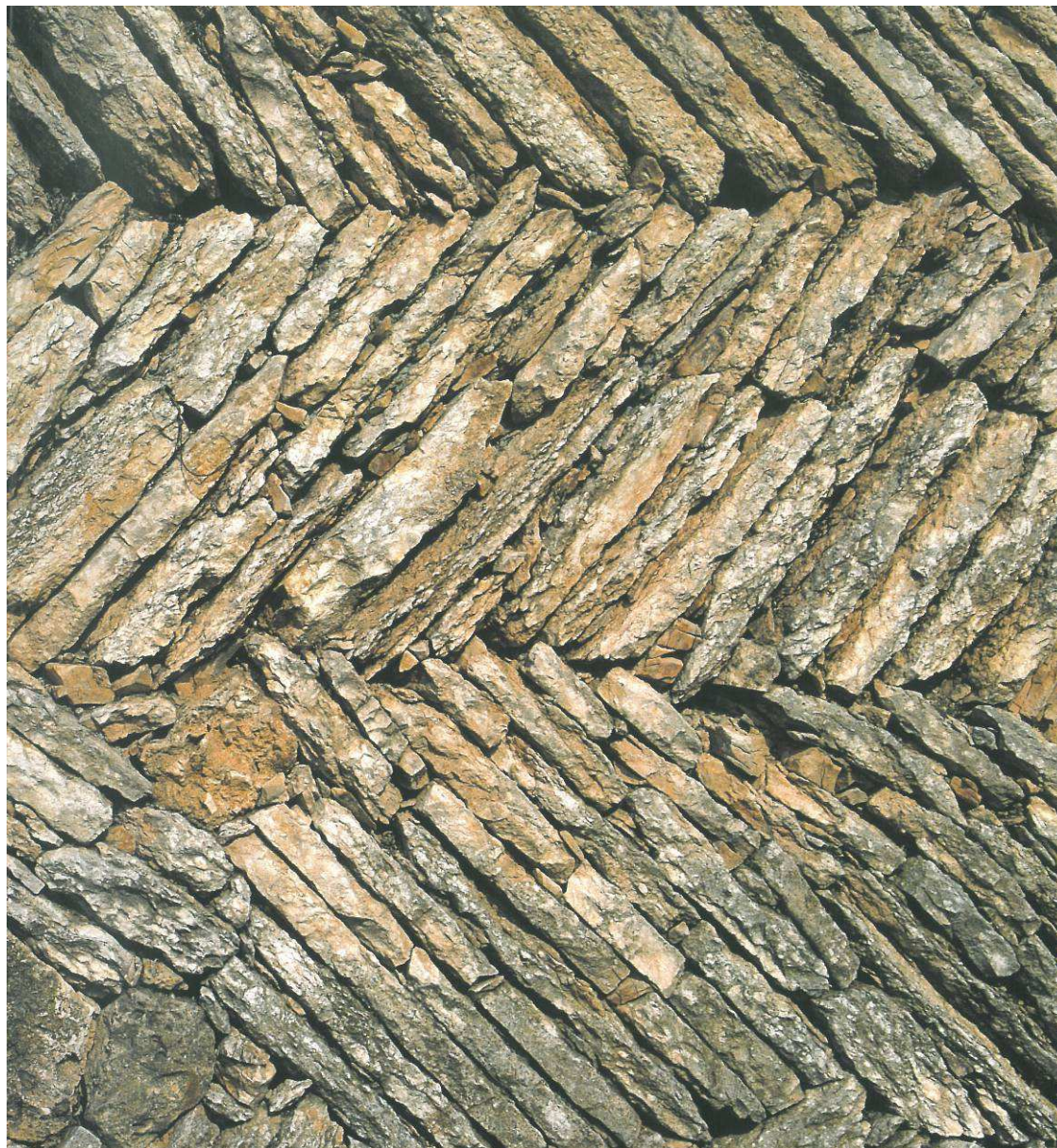
Dettaglio di muri a secco in laste di pietra disposte a lisca di pesce (immagine tratta dal libro “Valpolicella” di Fulvio Roiter)
