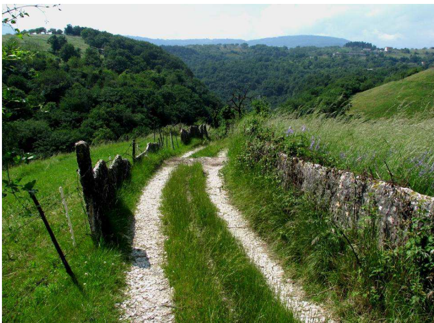
Muri a secco realizzati in laste verticali alle altitudini maggiori (archivio fotografico Consorzio per la Tutela dei Vini Valpolicella)
