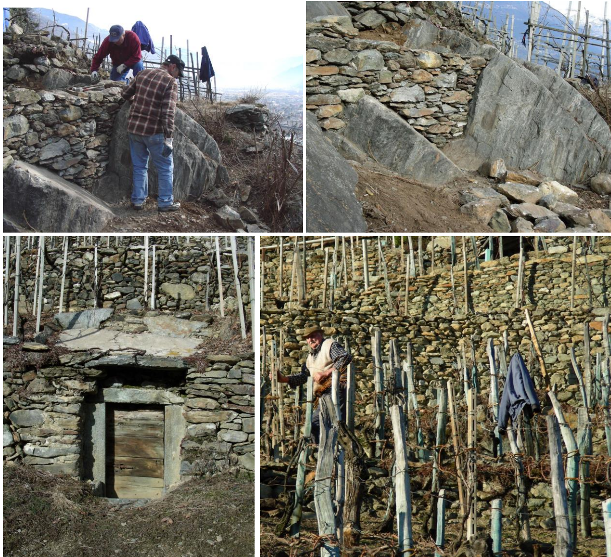
In foto: lavori in vigna, per la costruzione e rifacimento di un muretto a secco; deposito per gli attrezzi ricavato all'interno del vigneto.
