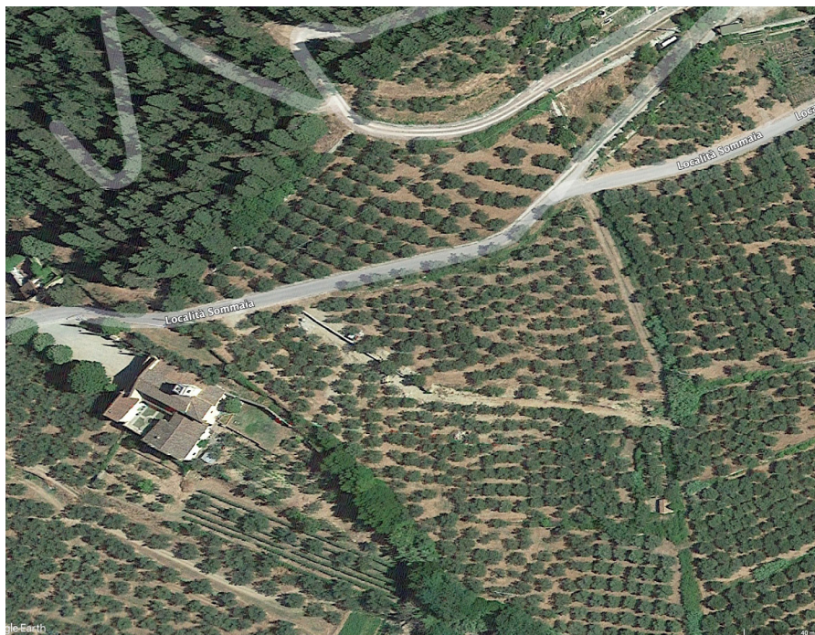
Sopra a sinistra: foto aerea del contesto in cui ricade l'area di indagine.
