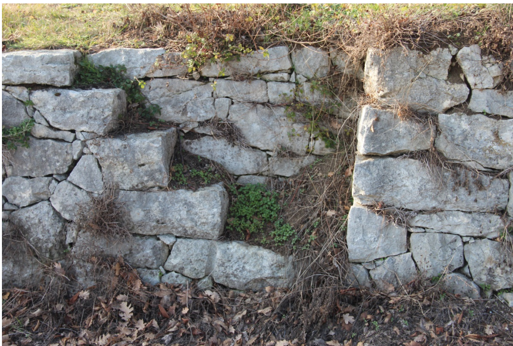
Scala in conci ricavata in un muretto a secco
