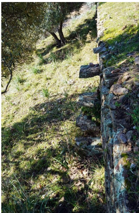
Foto 7a. Scalini infissi nel muro di sostegno
