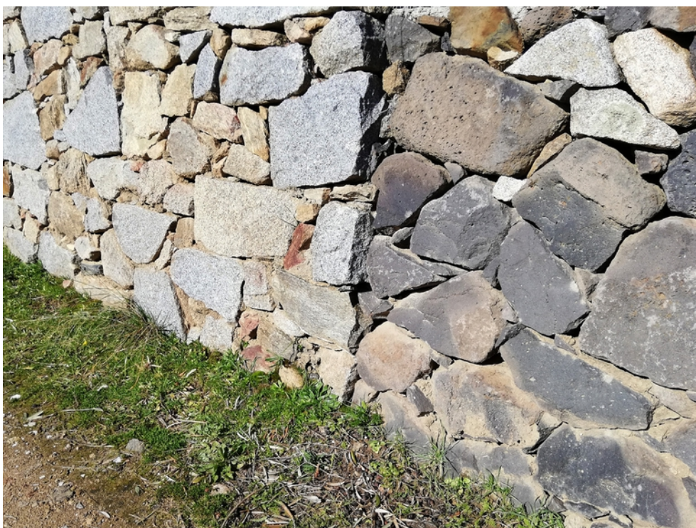
Foto 8. Dettaglio di un muro di sostegno in pietra a secco, realizzato con materiale litico locale appartenente a differenti tipologie geologiche (foto di M. Santona, 2019)
