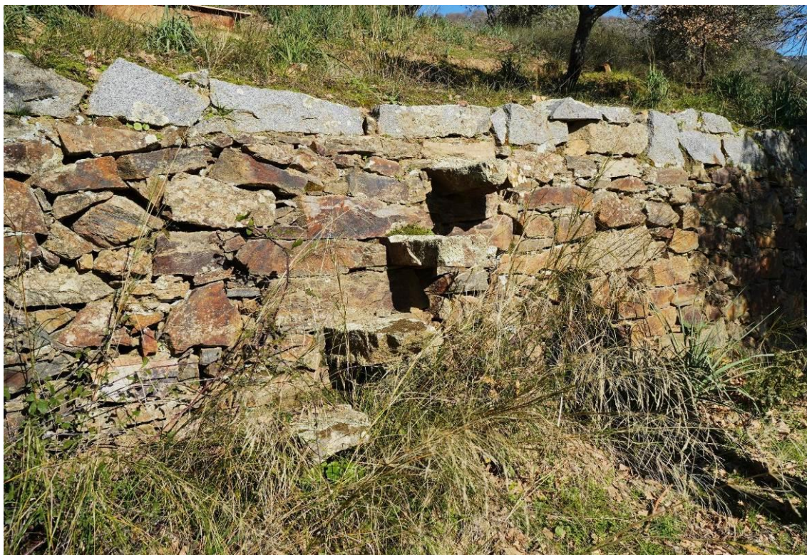
Foto 5a. Particolare degli scalini sui muri di sostegno della terrazza
