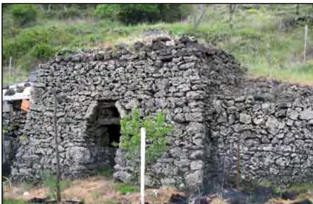
*Figura: Tipica “casedda”, costruzione agricola al servizio del fondo. Quando presenti, queste costruzioni sono di tipo semplice, mono o bicellulari, a elementi giustapposti, spesso con copertura a terrazza e scala di accesso.
