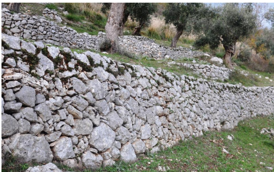
Fig. 18: esempio costruttivo dei muri a secco di Venafro, riconducibile alla tipologia dell' opus incerta .
