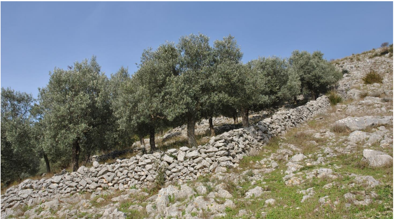
Terrazzamenti nella parte più alta dell'area, in località Le Noci
