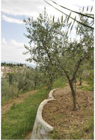
Figura 43 Sopra terrazzamenti ricostruiti con blocchi prefabbricati in cemento in località Collepino (frazione di Spello); sotto lunette a Trevi recuperate utilizzando il cemento nella muratura
